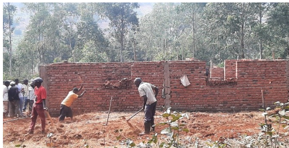
Travaux de terrassement
